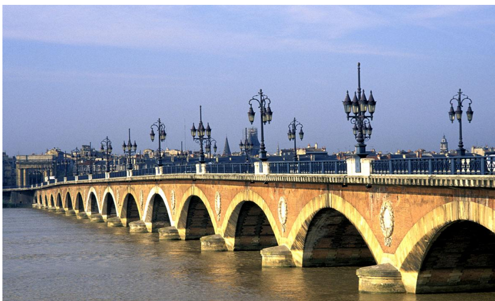
Uno de los puentes sobre el río Garona en la ciudad de Burdeos
